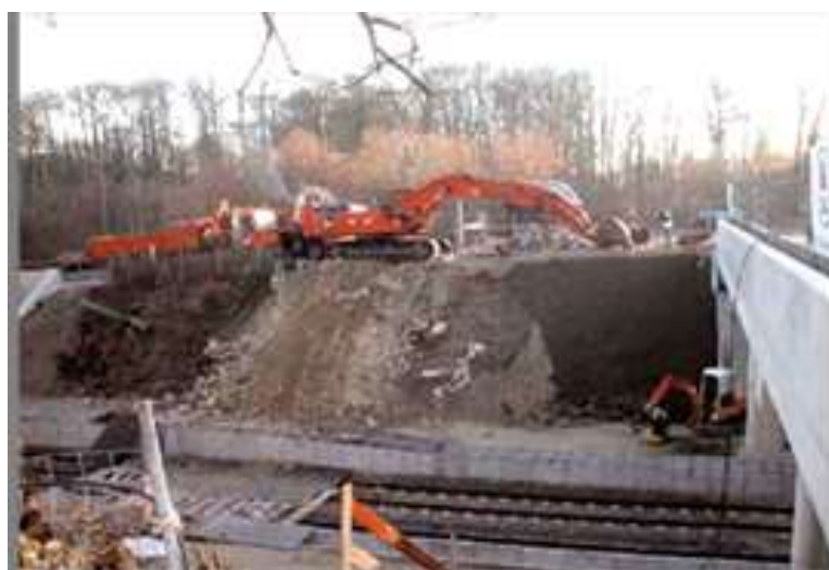
Opération de remblais
