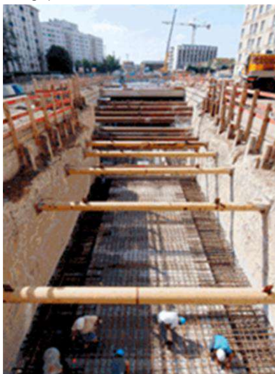
Exemple de tranchée couverte
