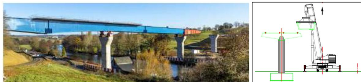
Illustration de lancement d'un tablier mixte (à gauche) et de la phase de pose des éléments préfabriqués par grutage (à droite) - (Systra - Etude préliminaire)
