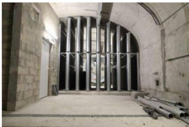
**Exemple de silencieux à baffles parallèles intégré dans un rameau de ventilation** (puits de ventilation ligne métro 4 - <http://www.rendezvousavecla4.fr>)
