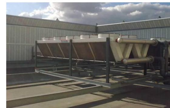
Exemple d'écrans antibruits autour d'un aéro-réfrigérant (ASM Acoustics)
